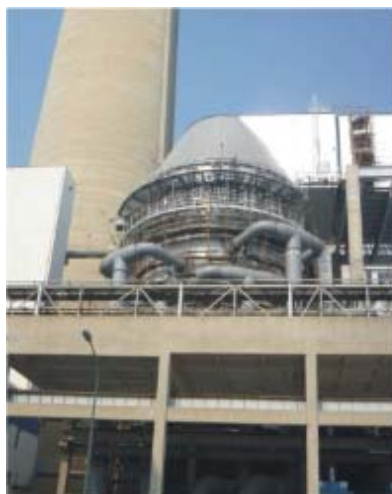
上海漕泾电厂2#机组1000MW 湿法脱硫超洁净排放改造项目
